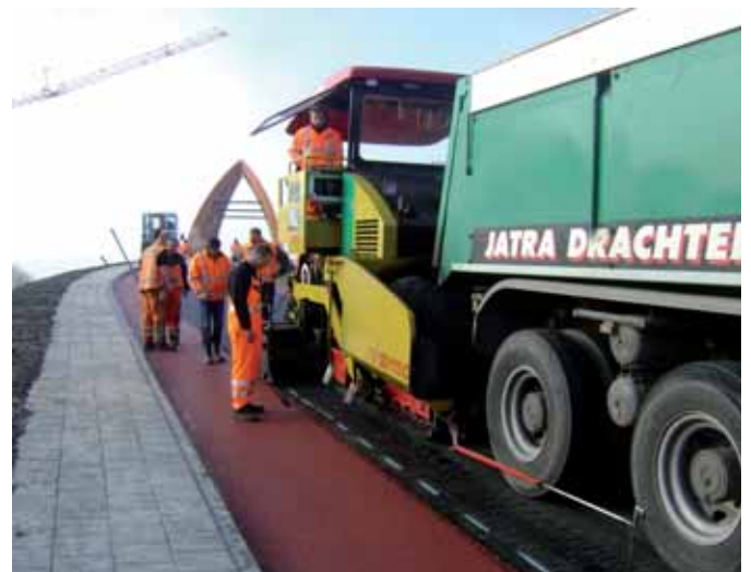
Aanbrengen asfaltverharding op toerit.
