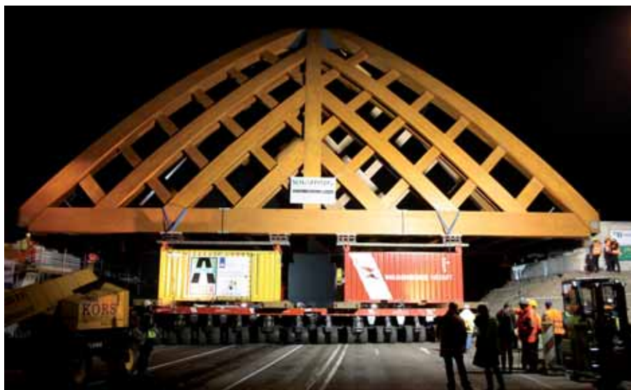
Onder grote belangstelling is de houten brug op 20 november 2010 over de A7 geplaatst.
