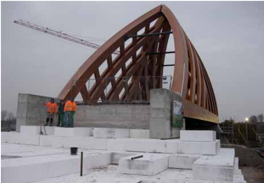
Toerit opgebouwd met ca. 1000 kubieke meter EPS om de zettingsperiode te verkorten.
