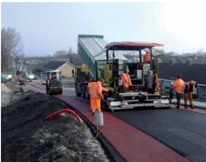
Zorgvuldige aansluiting van het asfalt op de net aangebrachte rode fietssuggestiestrook.
